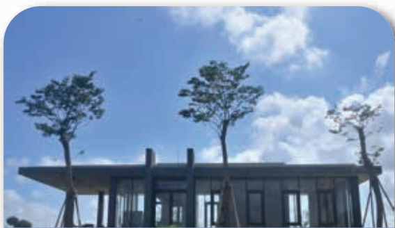
TRẠM DỪNG NGHỈ KIOS 06 Trong khuôn viên của Sân Golf Hoàng Gia - Ninh Bình
