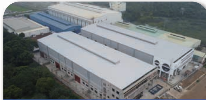
NHÀ XƯỞNG VĨNH KHANG - ĐÔNG ANH Diện tích 6400m 2 / sàn. Nhịp 10.5m. Hoạt tải 2T/m 2
